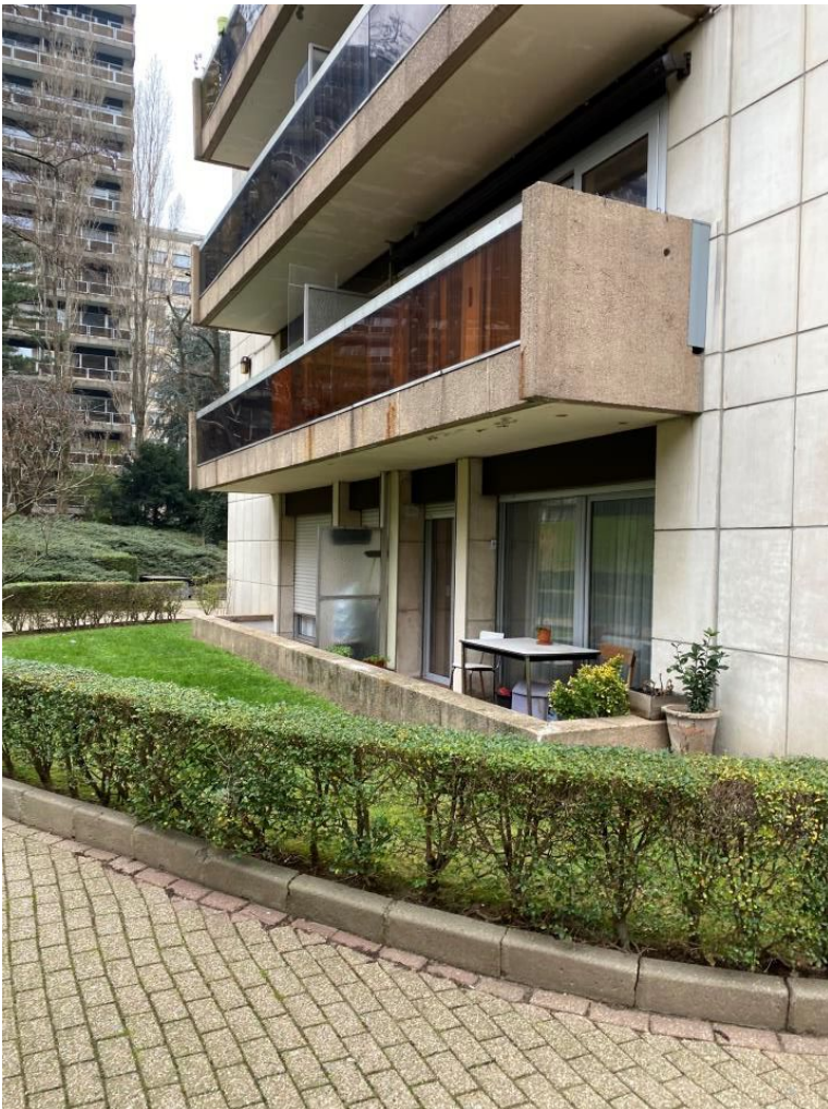
FACADE LATÉRALE GAUCHE
