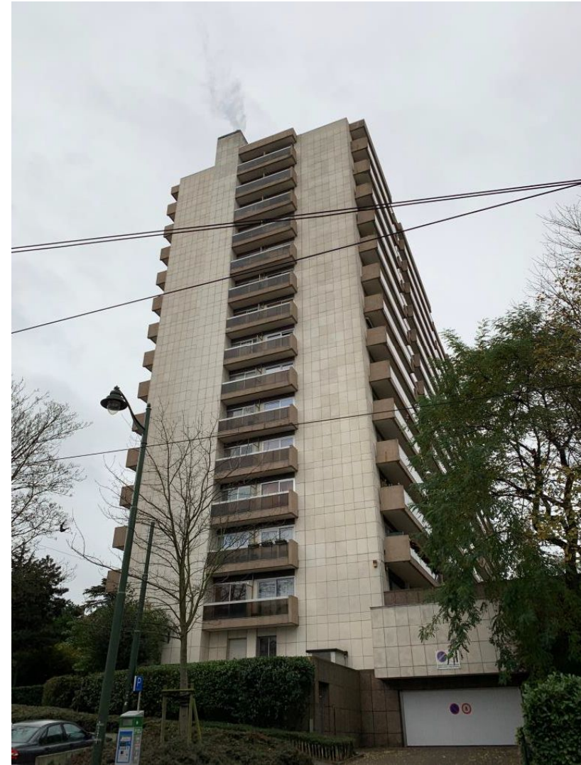
FACADE LATÉRALE DROITE
