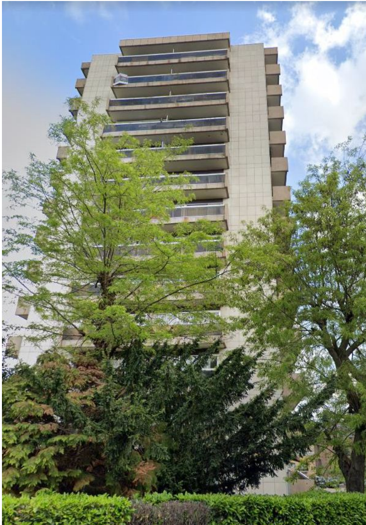
FACADE LATÉRALE GAUCHE
